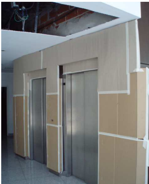
P.BAJA: PROTECCIONES DE REVESTIMIENTOS DE ASCENSORES.
