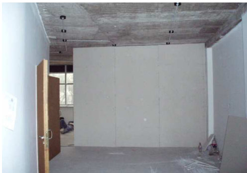
PISOS 3 Y 8: TENDIDO DE INSTALACION ILUMINACION Y TABIQUES DIVISORIOS INTERNOS
