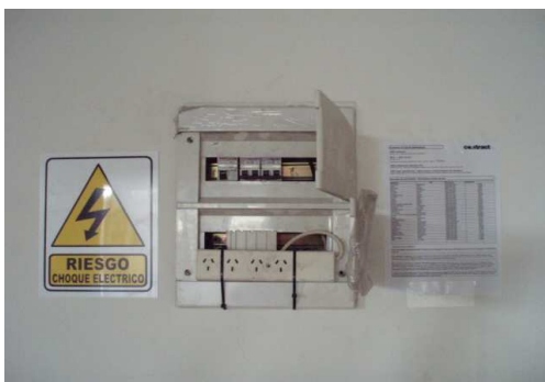
PISOS GENERALES: SEÑALIZACION Y ARMADO TABLERO DE OBRA EN CADA PISO A INTERVENIR.
