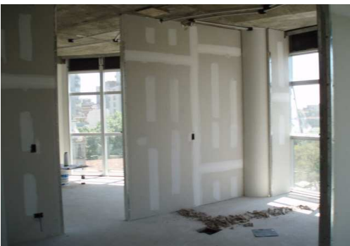
PISO 8: PICADO CANALIZACIONES .EMPLACADO DE TABIQUES Y MASILLADO DE JUNTAS
