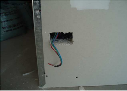
PISO 9: CABLEADO CIRCUITOS TOMAS USO GENERAL.
