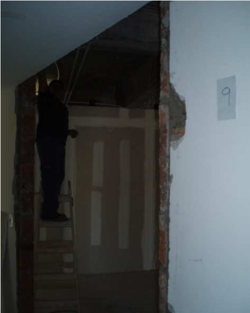
PISO 9: DEMOLICION PUERTA HALL ACCESO Y RECUADRADO VANO .
