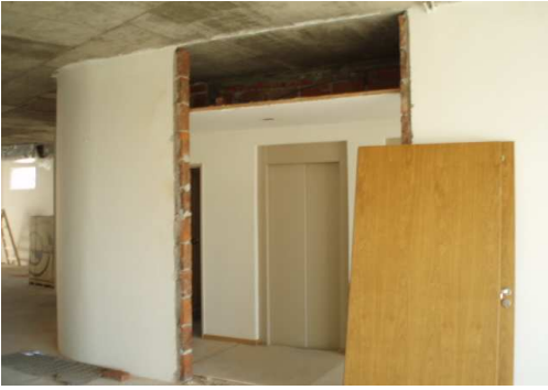
PISO 7: INICIO OBRAS . DESMONTAJE PUERTA HALL ACCESO.
