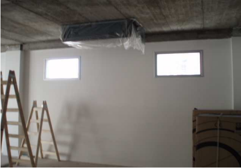
PISO 7: COLGADO EVAPORADORAS DE AIRE ACONDICIONADO S/ LOSA SUPERIOR.
