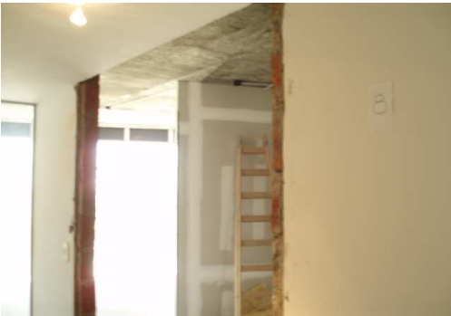
PISO 8: DESMONTAJE PUERTA HALL ACCESO Y RECUADRADO DE VANO
