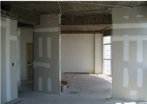
EMPLACADO Y MASILLADO TABIQUES, COLGADO EVAPORADORAS Y TENDIDO CAÑERIA ILUMINACION PISO 9.
