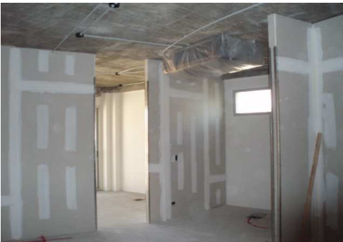
PISO 8: EMPLACADO Y MASILLADO TABIQUES, COLGADO EVAPORADORAS Y TENDIDO CAÑERÍA ILUMINACION .
