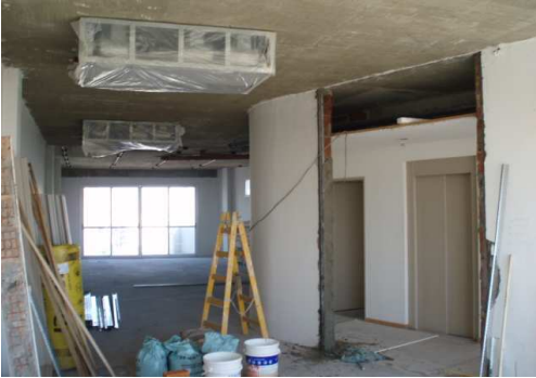
PISO 10: COLGADO EVAPORADORAS (Y PROTECCION), DEMOLICION PUERTA HALL ACCESO Y RECUADRADO VANOS .
