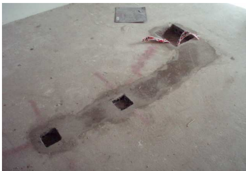
TENDIDO CAÑERÍA PUESTOS DE TRABAJO + AMURADO Y TAPADO PISO 03
