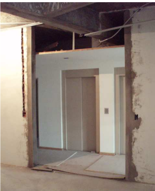
RECUADRO VANO PISO 10
