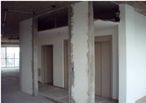
RECUADRO VANO PUERTA HALL Y ESQUINA POR DEMOLICION VENTANA EXISTENTE. PISO 10
