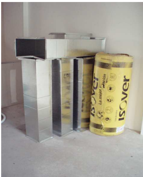
ACOPIO DE CONDUCTOS PISO 03
