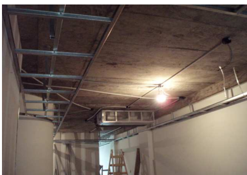
COMIENZO AJUSTES CIELORRASO PISO 03
