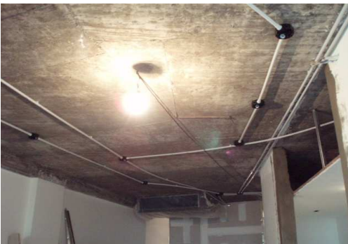
PISO 08: TENDIDO CAÑERÍA DETECCIÓN INCENDIO
