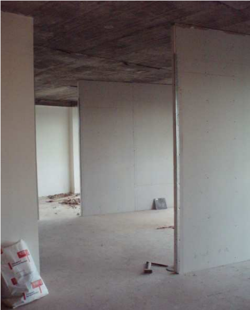
ARMADO Y EMPLACADO UNA CARA PISO 07
