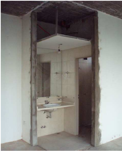
DEMOLICION Y RECUADRO BAÑO PISO 09
