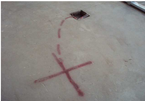
REPLANTEO DEFINITIVO PUESTOS DE TRABAJO EN LOS 5 PISOS A INTERVENIR
