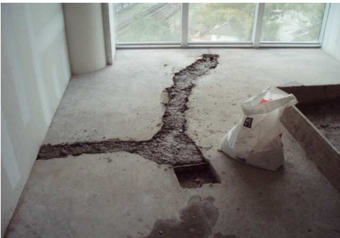
TENDIDO CAÑERÍA PUESTOS DE TRABAJO + AMURADO Y TAPADO PISO 08
