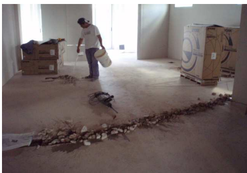
PICADO CANALIZACIONES PISO 07
