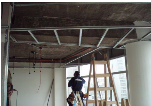
COMIENZO ESTRUCTURA DE AJUSTES DE CIELORRASO PISO 09
