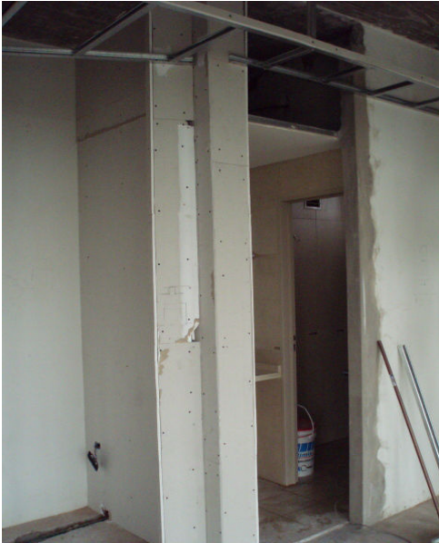
CIERRE EN PLACA ROCA DE YESO BAÑO EMBAJADOR PISO 09
