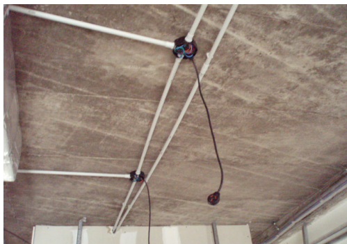
CABLEADO ILUMINACION Y COLOCACION CHICOTES PISOS 08 Y 09
