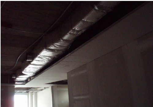
COMIENZO EMPLACADO AJUSTES DE CIELORRASO PISO 07
