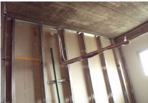
TENDIDO DE CAÑERIA Y DESAGÜE PARA SPLIT DATA CENTER.
