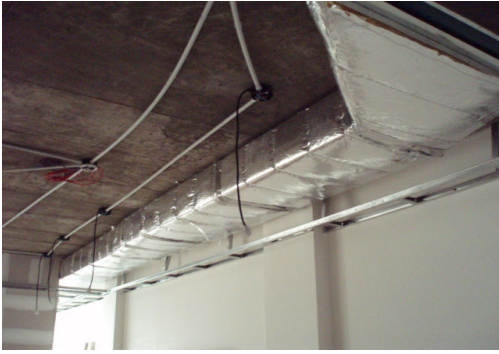
COLGADO DE CONDUCTOS DE AA PISO 08
