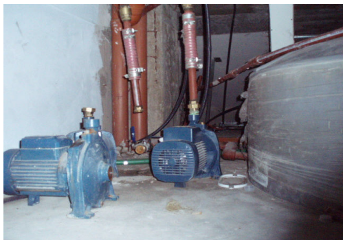
RETIRO BOMBAS EXISTENTES PARA REPARACION E INSTALACION BOMBA NUEVA (EXISTENTE EN OBRA)
