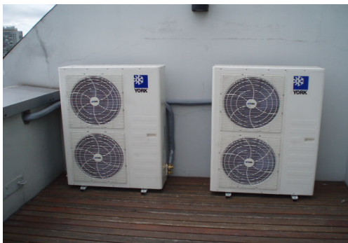
INSTALACION Y CONEXIÓN UNIDADES CONDENSADORAS PISO 10.
