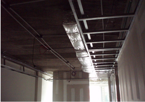
ARMADO ESTRUCTURA DE AJUSTES DE CIELORRASO PISO 08
