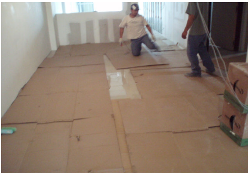
COMIENZO COLOCACION PORCELANATO PISO 03
