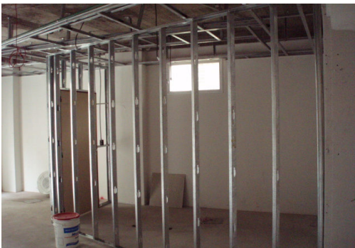
ARMADO ESTRUCTURA NUEVOS DEPOSITOS PISOS 03 Y 08
