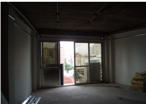
INSTALACION Y CONEXIÓN UNIDADES CONDENSADORAS PISO 09.
