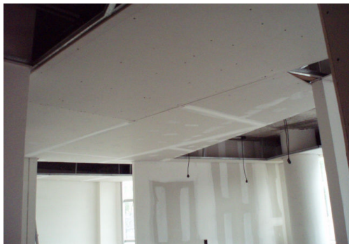
COMIENZO EMPLACADO Y MASILLADO AJUSTES CIELORRASO PISO 03
