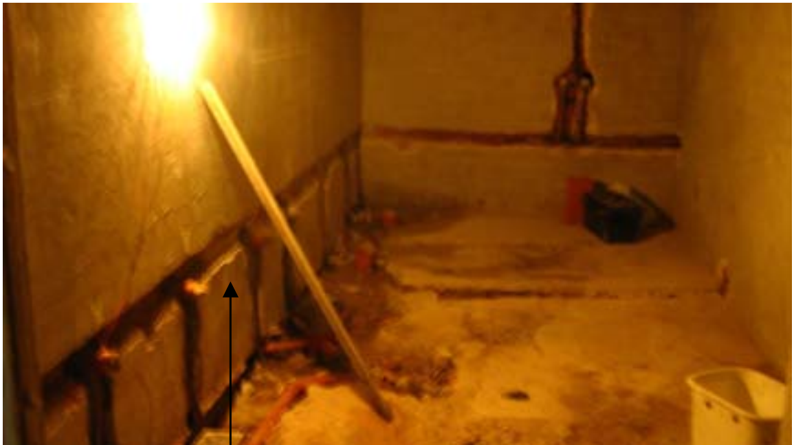
Tendido de instalación cloacal, Sala Hidroterapia.
