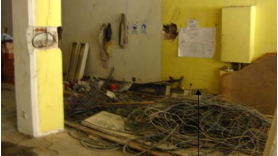
Retiro de cableado telefónico y otros
