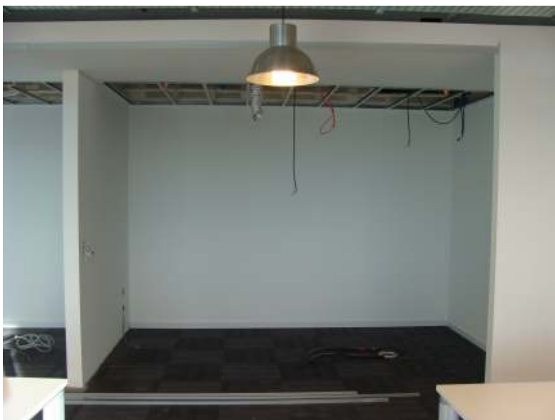
Fotos 3 y 4 – Puestos de trabajo: Vista hacia sala de directorio. Abajo, detalle de sala en espera para recibir los equipos de aire acondicionado tipo cassette. Perfilera para cristales y zócalos colocados.
