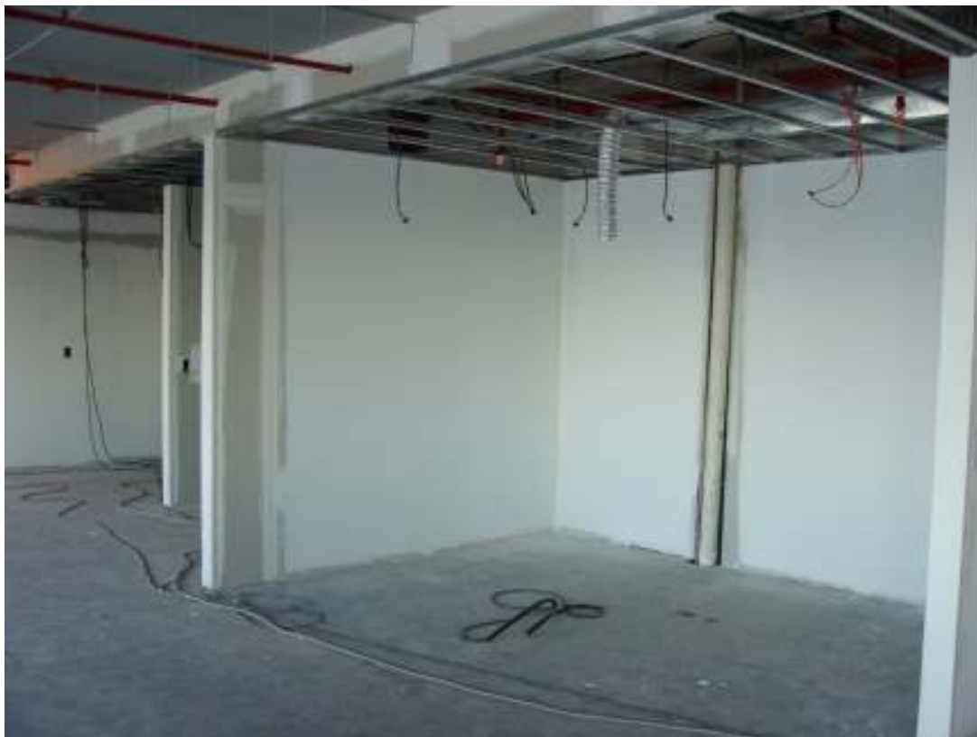
Foto 10 – Salas: VTabiques terminados. Conductos de renovación de aire terminados. Acometida hacia puestos terminada y bocas de iluminación previstas.
