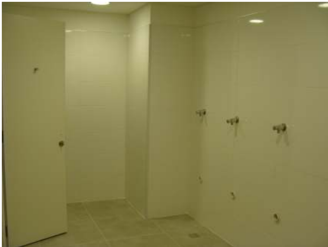
Foto 7 – Baño de hombres: Mingitorios listos para instalarse. Puerta acceso a retrete con percha y cantonera en arista de columna.
