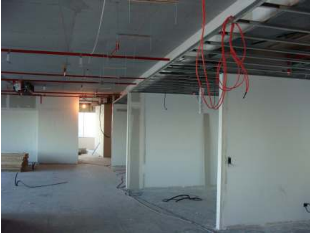
Fotos 8 y 9 – Puestos de trabajo: Vista hacia coffe. Tabiques terminados, estructura de cieloraso sobre salas. Sprinklers y detección de incendio terminados. Sujeciones de bandejas y equipos de aire colgados.
