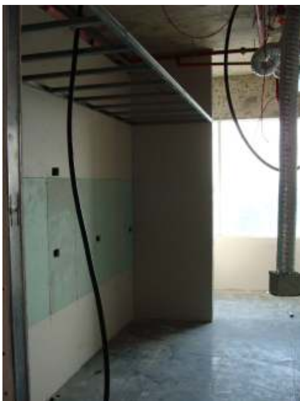
Foto 10 – Salas: VTabiques terminados. Conductos de renovación de aire terminados. Acometida hacia puestos terminada y bocas de iluminación previstas.
