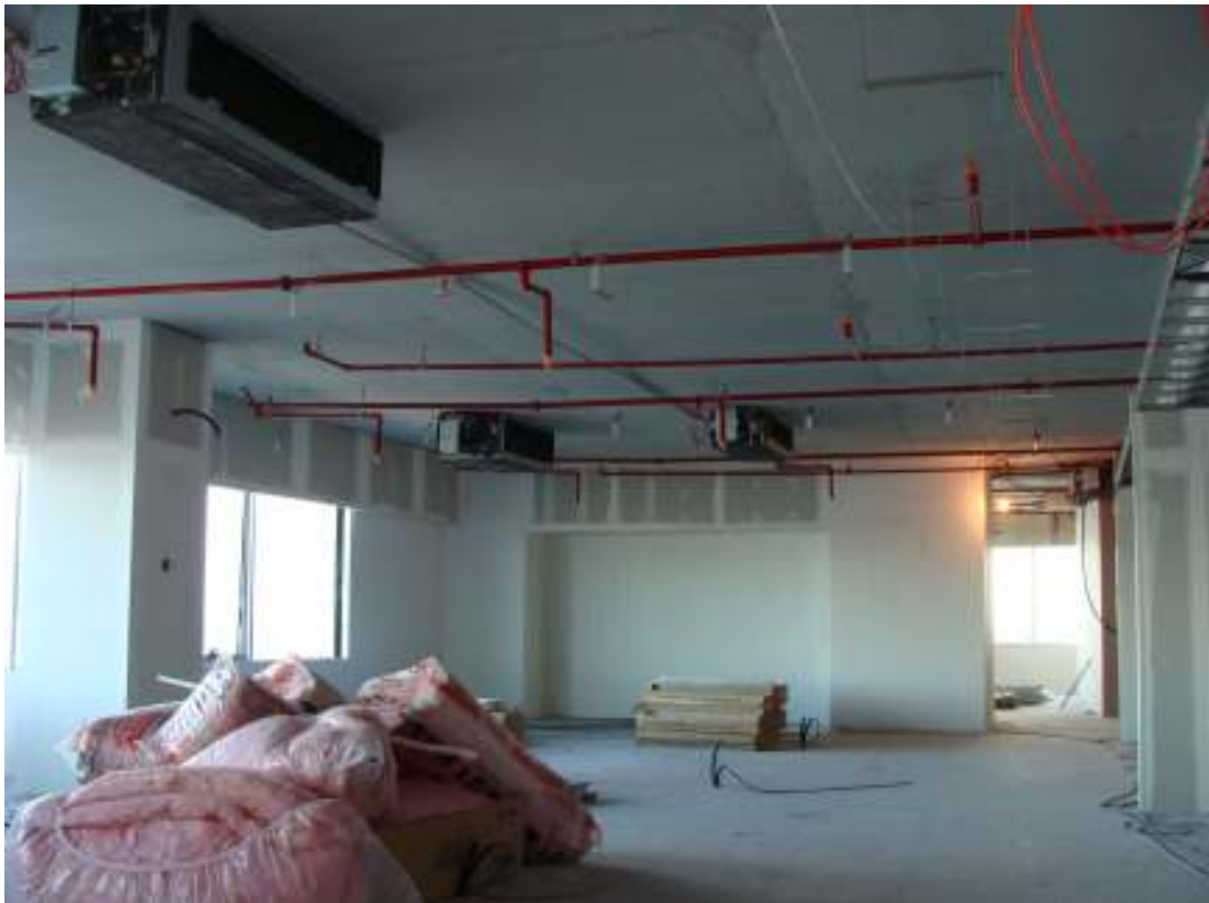
Fotos 8 y 9 – Puestos de trabajo: Vista hacia coffe. Tabiques terminados, estructura de cieloraso sobre salas. Sprinklers y detección de incendio terminados. Sujeciones de bandejas y equipos de aire colgados.
