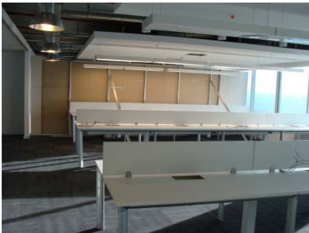
Fotos 1 y 2 – Puestos de trabajo: Cerco con etapa 1. Puestos en proceso de armado al igual que cableado. Alfombra e iluminación terminados. Huecos en cielorraso preparados para recibir difusores de aluminio.
