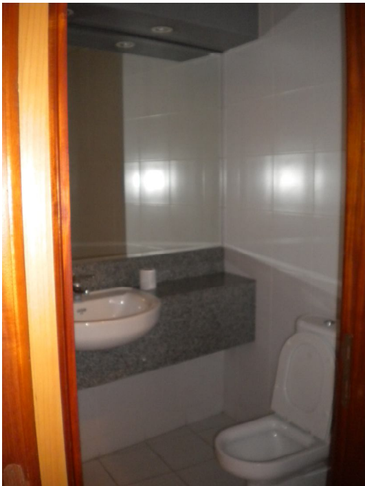
BAÑO A DEMOLER
