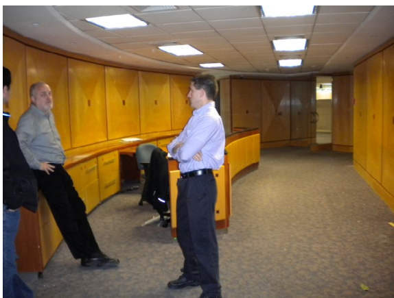
VISTA ACCESO – REVESTIMIENTO MADERA
