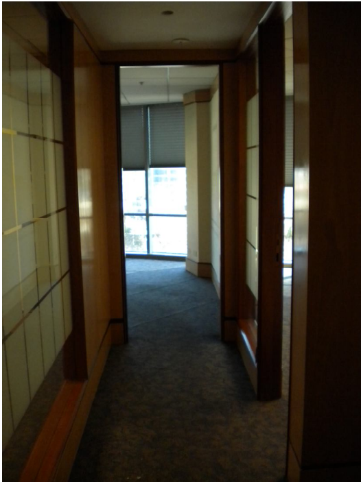
VIDRIOS Y PANELES A DEMOLER
