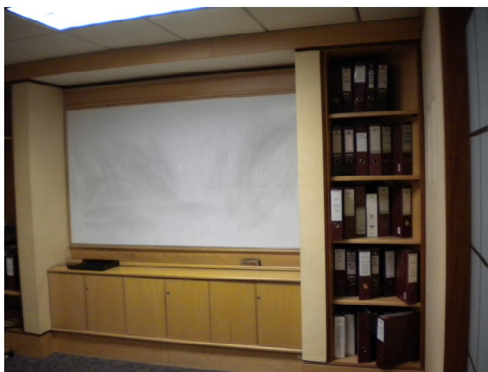
INTERIOR DE OFICINA A DEMOLER
