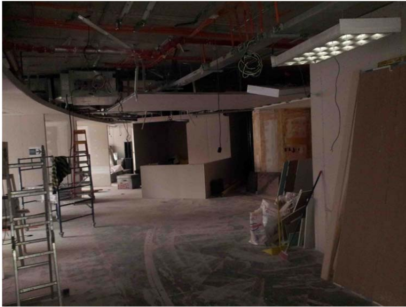
FOTO 3 – VISTA LATERAL DERECHO
