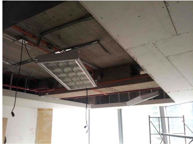
FOTO 4 – VISTA PROA - CIELO
