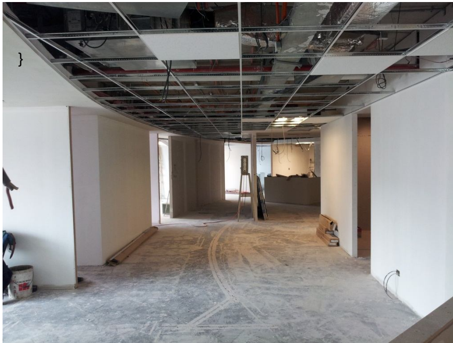
FOTO 3 – VISTA LATERAL DERECHO
