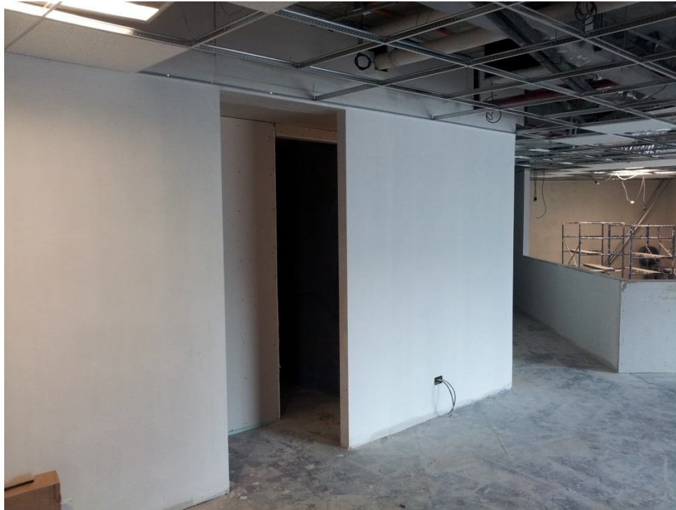
FOTO 5 – VISTA ACCESO BAÑOS
