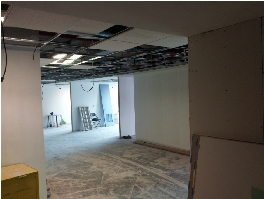
FOTO 1 – VISTA TABIQUE SALA DE REUNIONES
