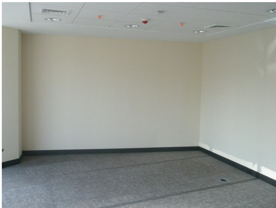
Foto 1_ Oficinas. Se realizó limpieza de las oficinas. Falta limpieza fina de terminación.
