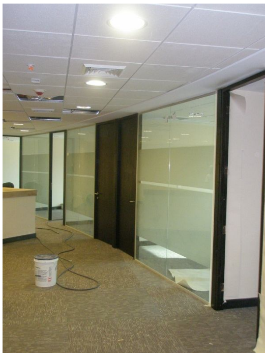
Fotos 2 y 3_Films. Se colocaron films en vidrios oficinas, puerta ppal y puertas protex laterales
