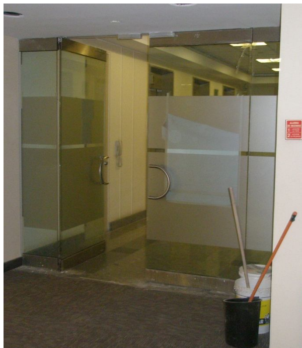
Fotos 2 y 3_Films. Se colocaron films en vidrios oficinas, puerta ppal y puertas protex laterales
