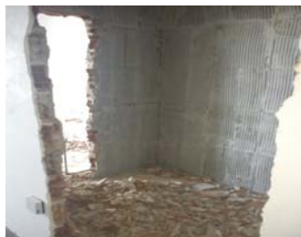
Demolicion Sanitarios Discapacitados Norte 3°
