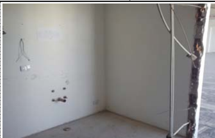
Demolicion Office (Sala de Cableado) 3° al 11°
