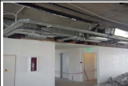
Demolicion Cielorraso Oficinas Norte 3° al 10°
