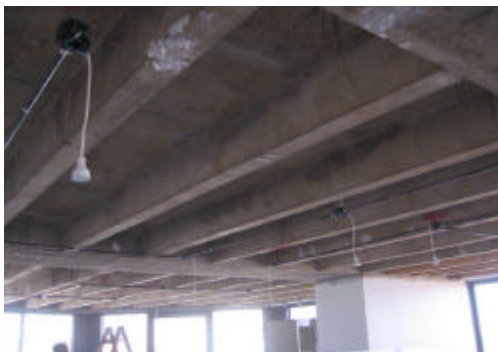
MONTAJE DE NUEVAS CAÑERÍAS METÁLICAS PARA INSTALACIÓN DE ILUMINACIÓN Y CABLEADO SEGÚN NORMAS VIGENTES
