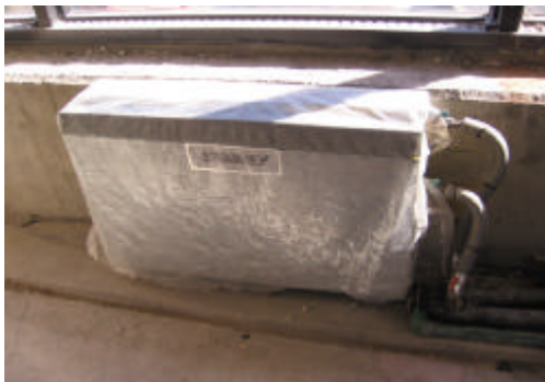
DESARMADO DE MUEBLES CUBRE FANCOIL, PROTECCIÓN DE LOS APARATOS, PRUEBA DE DRENAJES Y NUEVA ALIMENTACIÓN ELÉCTRICA
