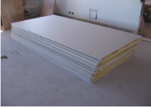
NUEVO ACOPIO DE MATERIALES PARA EJECUCIÓN DE NUEVOS TABIQUES Y CIELORRASOS
