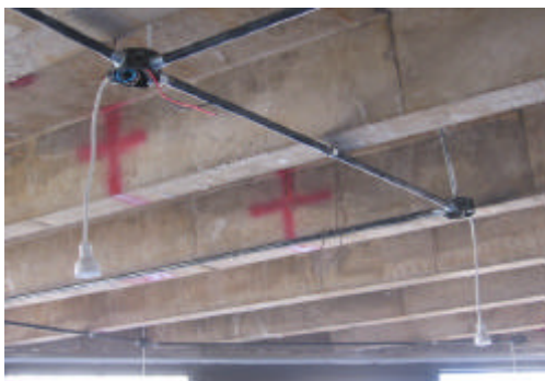
MONTAJE DE CHICOTES HEMBRA PARA ALIMENTACIÓN DE NUEVOS ARTEFACTOS DE ILUMINACIÓN SEGÚN NORMAS VIGENTES
