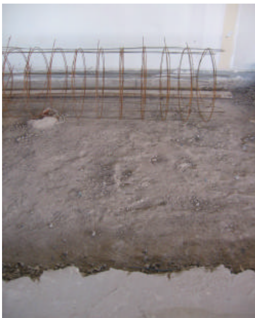
PICADO DE CONTRAPISO PARA EJECUCIÓN DE REFUERZO ESTRUCTURAL BAJO ARCHIVOS DESLIZANTES
