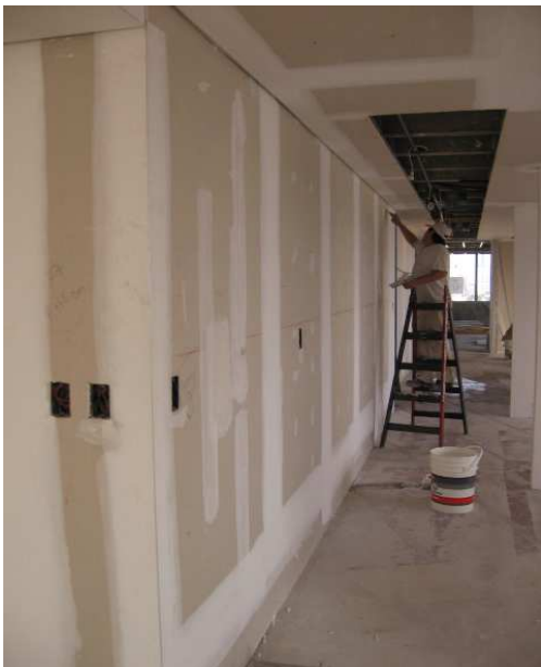
ENCINTADO Y MASILLADO DE JUNTAS DE NUEVOS TABIQUES EN CIRCULACIÓN PRINCIPAL
