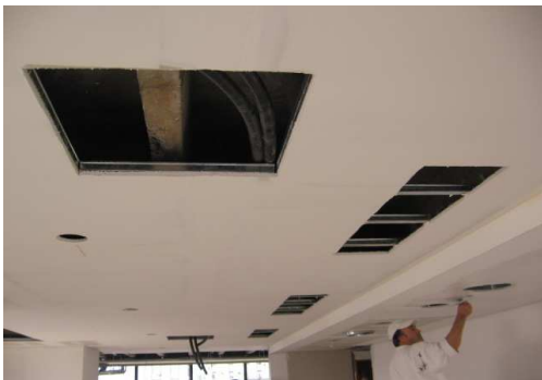
ENDUÍDO COMPLETO DE CIELORRASOS Y EJECUCIÓN DE HUECOS PARA ARTEFACTOS DE ILUMINACIÓN EN ALA SUR
