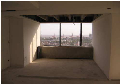
ENDUÍDO COMPLETO DE NUEVOS TABIQUES DIVISORIOS ALA SUR
