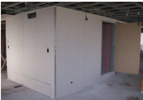
EJECUCIÓN DE CIERRE PERIMETRAL DE NUEVO DATA CENTER CON PLACA IGNÍFUGA
