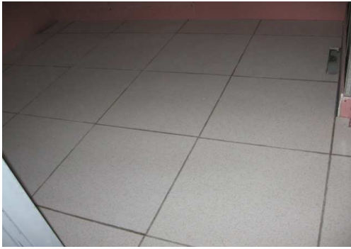
COLOCACIÓN DE PISO TÉCNICO ELEVADO CON TERMINACIÓN PLÁSTICA ANTIESTÁTICA EN NUEVO DATA CENTER
