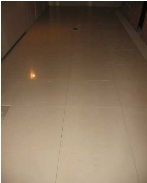
COLOCACIÓN DE PORCELLANATTO EN HALL ACCESO
