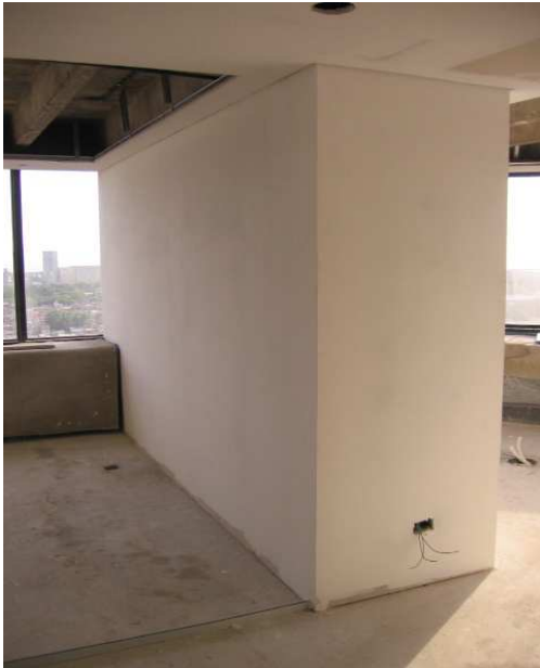
ENDUÍDO COMPLETO DE NUEVOS TABIQUES DIVISORIOS EN ALA SUR
