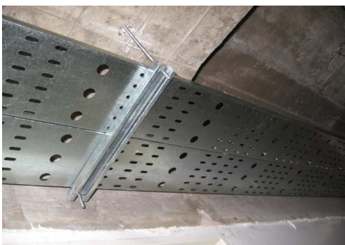
COLOCACIÓN DE BANDEJAS TRONCALES DE DISTRIBUCIÓN FRENTE A PLENOS PRINCIPALES
