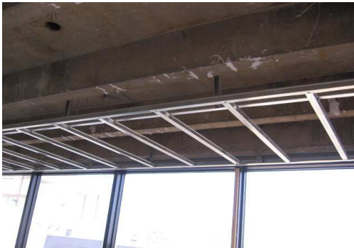
EJECUCIÓN DE ESTRUCTURA DE AJUSTES PERIMETRALES DE CIELORRASOS EN ALA NORTE
