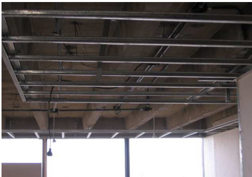
EJECUCIÓN DE ESTRUCTURA DE CAJONES DE CIELORRASOS EN ALA NORTE
