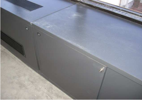
LIMPIEZA Y PUESTA A PUNTO DE MUEBLES CUBRE FANCOIL PERIMETRALES
