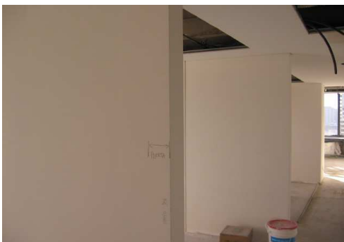
APLICACIÓN DE PRIMERA MANO DE LÁTEX EN CIELORRASOS Y TABIQUES
