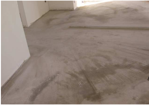
EJECUCIÓN DE CARPETA DE NIVELACIÓN FINAL
