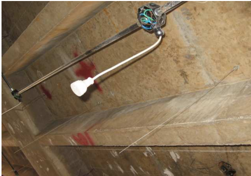
COLOCACIÓN DE TENSORES PARA FIJACIÓN DE CIELORRASO DESMONTABLE
