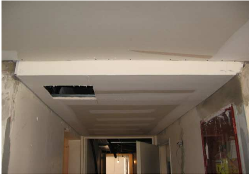
EJECUCIÓN DE CIELORRASOS EN CIRCULACIONES DE SERVICIO
