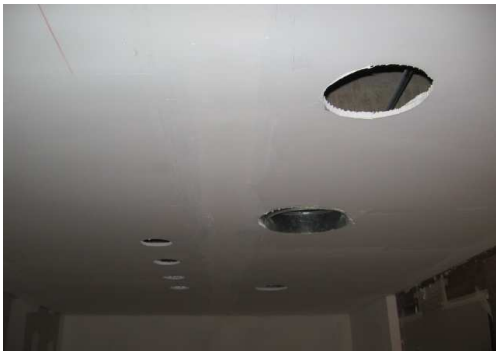
EJECUCIÓN DE HUECOS PARA ARTEFACTOS DE ILUMINACIÓN E INYECCIÓN DE AIRE ACONDICIONADO
