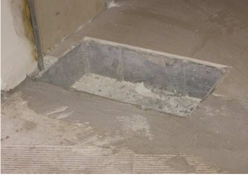
COLOCACIÓN DE CAJAS DE FRENO EN CONTRAPISO PARA PUERTAS DE CRISTAL TEMPLADO
