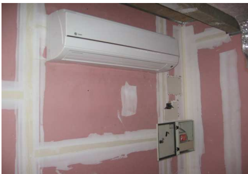
INSTALACIÓN DE EQUIPO DE AIRE ACONDICIONADO Y BOMBA DE DESAGUE EN DATA CENTER
