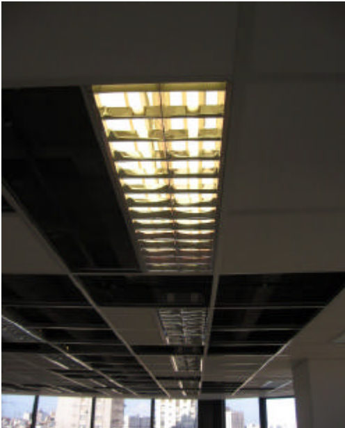
COLOCACIÓN DE PLACAS Y ARTEFACTOS DE ILUMINACIÓN EN CIELORRASOS DESMONTABLES
