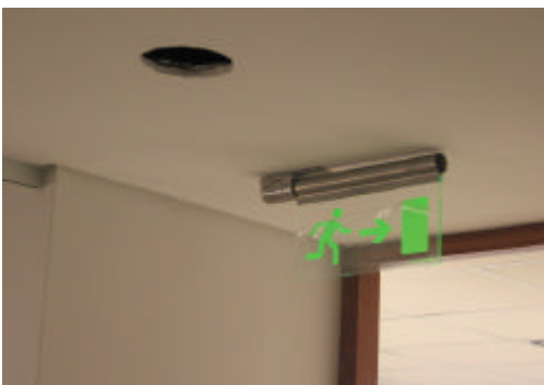
INSTALACIÓN DE CARTELES DE SALIDA DE EMERGENCIA
