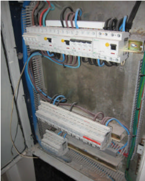
ARMADO DE TABLEROS DE ILUMINACIÓN
