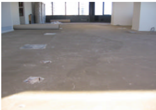
EJECUCIÓN DE MASA NIVELADORA BAJO ALFOMBRA
