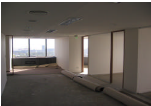
COLOCACIÓN DE ALFOMBRA EN ROLLO
