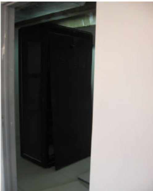
INSTALACIÓN DE RACK EN DATA CENTER
