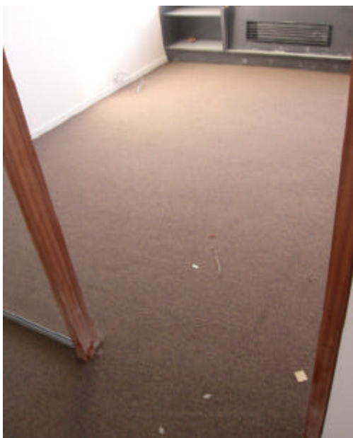
COLOCACIÓN DE MARCOS DE PUERTAS Y PERFILES DE ALUMINIO PARA SUJECCIÓN DE CRISTALES
