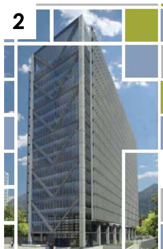
EDIFICIO CERRO EL PLOMO 6000
