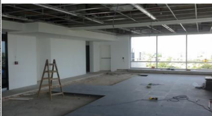
Desmonte de Piso tecnico para tendido de bandejas
