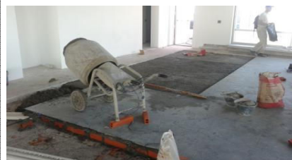
Ejecucion de Contrapiso para la colcoacion de Porcellanato
