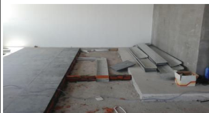
Ejecucion de Muro bajo tabique de Data Center
