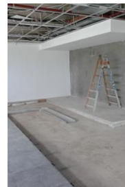
Ejecucion de Contrapiso para la colcoacion de Porcellanato
