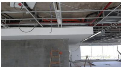
Desmonte de Piso tecnico para tendido de bandejas
