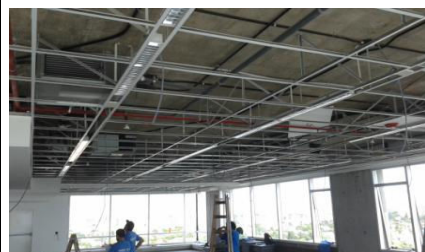
Retiro de Cielorraso
