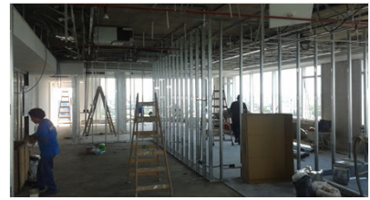
Ejecucion de Estructura de tabiquería de Placa roca de yeso
