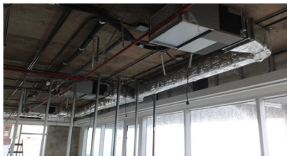
Presentacion de Conductos para la distribucion de aire acondicionado
