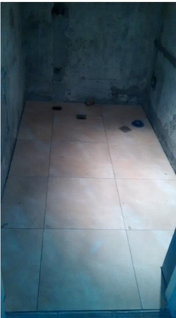
Handicap Toilet: Porcelanato tile installed.-
