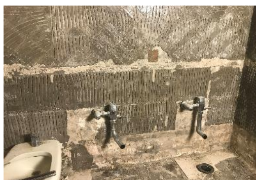
DESMONTE DE REVESTIMIENTOS EN BAÑOS EXISTENTES
