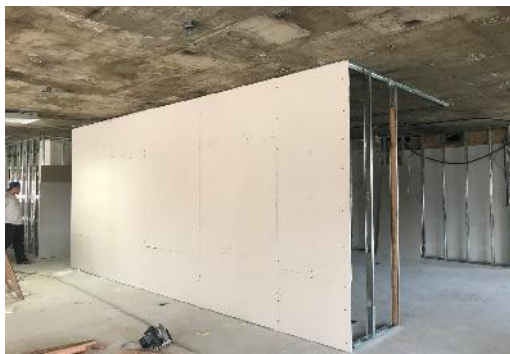
TABIQUE DE ROCA DE YESO - ESTRUCTURA Y 1 PLACA - REVOQUES EN BAÑOS
