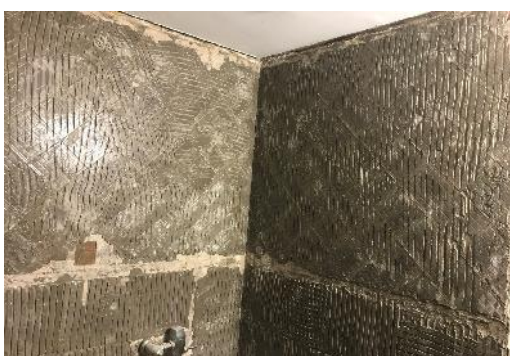
TABIQUE DE ROCA DE YESO - ESTRUCTURA Y 1 PLACA - REVOQUES EN BAÑOS
