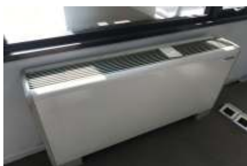
FANCOILS DE AIRE ACONDIONADO PROBADOS TODOS FUNCIONANDO MENOS 3 - VER UBICACION EN PLANO CORRESPONDIENTE
