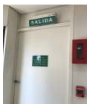
SALIDAS DE ESCAPE EXISTENTES A MANTENER - DETECTORES EXISTENTES A REUBICAR SEGÚN NUEVO LAYOUT CON PROVEEDOR DEL EDIFICIO
