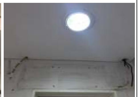
SALIDAS DE ESCAPE EXISTENTES A MANTENER - DETECTORES EXISTENTES A REUBICAR SEGÚN NUEVO LAYOUT CON PROVEEDOR DEL EDIFICIO
