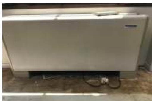
FANCOILS DE AIRE ACONDIONADO PROBADOS TODOS FUNCIONANDO MENOS 3 - VER UBICACION EN PLANO CORRESPONDIENTE
