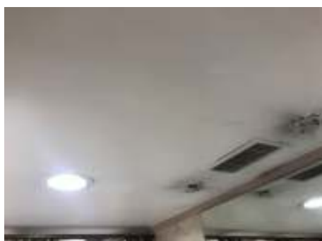
SALIDAS DE ESCAPE EXISTENTES A MANTENER - DETECTORES EXISTENTES A REUBICAR SEGÚN NUEVO LAYOUT CON PROVEEDOR DEL EDIFICIO
