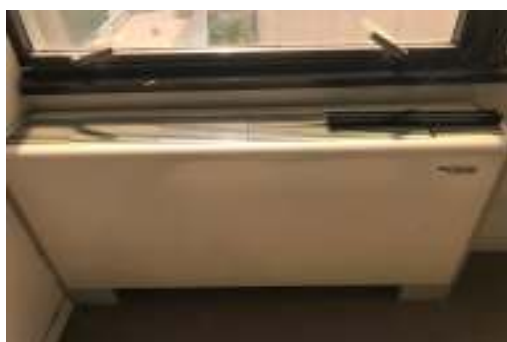
FANCOILS DE AIRE ACONDIONADO PROBADOS TODOS FUNCIONANDO MENOS 3 - VER UBICACION EN PLANO CORRESPONDIENTE
