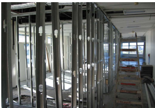
EJECUCIÓN DE ESTRUCTURA METÁLICA PARA NUEVA TABIQUERÍA EN PLACA DE ROCA DE YESO
