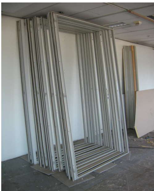
DESMONTAJE DE TABIQUERÍA MODULAR EXISTENTE Y REEMPLAZO DE CRISTALES PARA SU REUTILIZACIÓN
