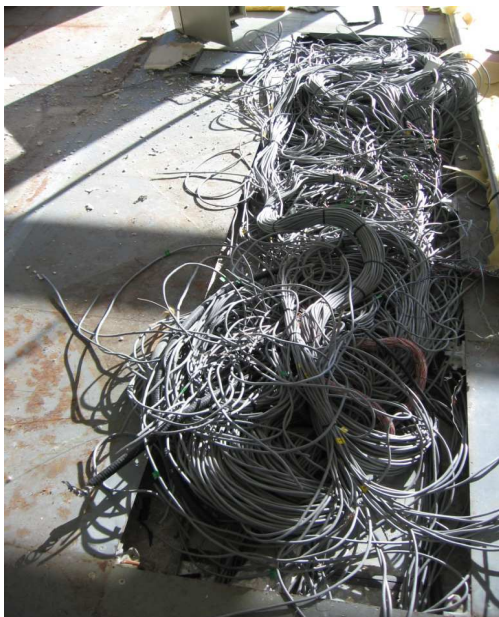
DESCABLEADO DE INSTALACIONES EXISTENTES BAJO PISO TÉCNICO
