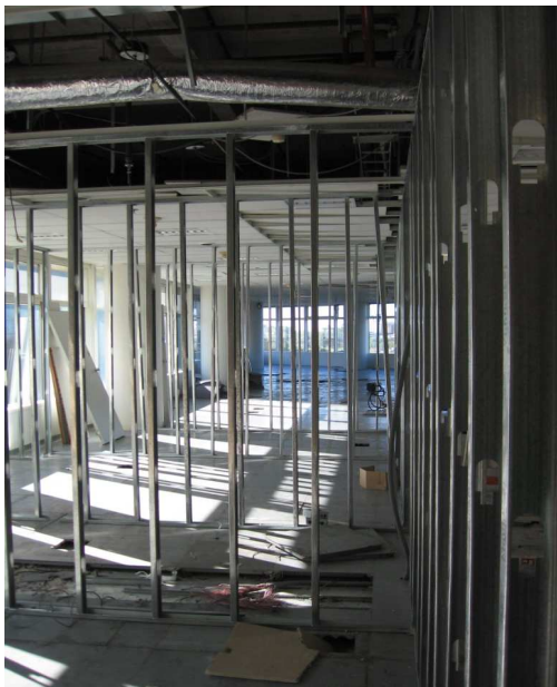
EJECUCIÓN DE ESTRUCTURA METÁLICA PARA NUEVA TABIQUERÍA EN PLACA DE ROCA DE YESO
