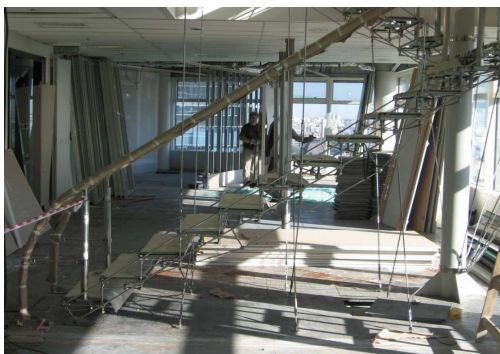
ESCALERA DE CRISTAL TEMPLADO Y ACERO EXISTENTE A REACONDICIONAR
