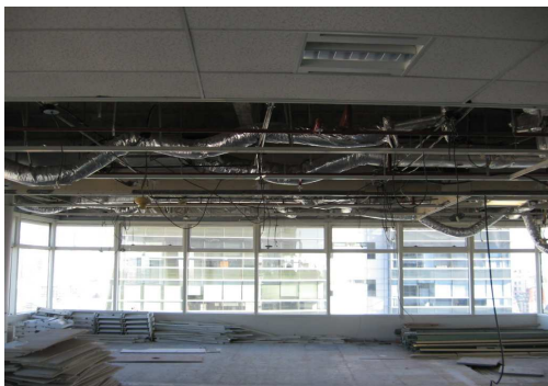
DESMONTAJE PARCIAL DE CIELORRASOS PARA MODIFICACIÓN DE INSTALACIÓN DE AIRE ACONDICIONADO
