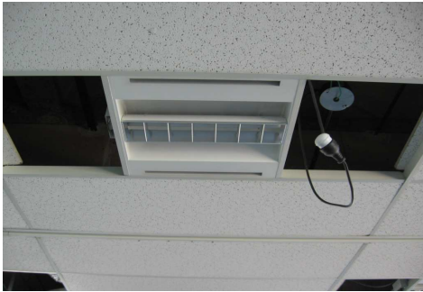
PUESTA A PUNTO Y REINSTALACION DE ARTEFACTOS EXISTENTES SEGUN NORMATIVAS VIGENTES - INSTALACION DE FICHAS MACHO Y HEMBRA
