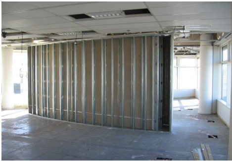
TABIQUES CURVOS EN COFFEES - ESTRUCTURA METALICA Y EMPLACADO DE CARA UNO
