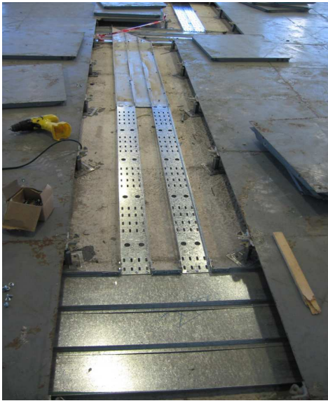
TENDIDO DE NUEVAS BANDEJAS BAJO PISO TECNICO
