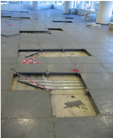
RETIRO DE PLACAS DE PISO TECNICO AGUJERADAS Y DANADAS PARA SU REPARACION Y RECOLOCACION
