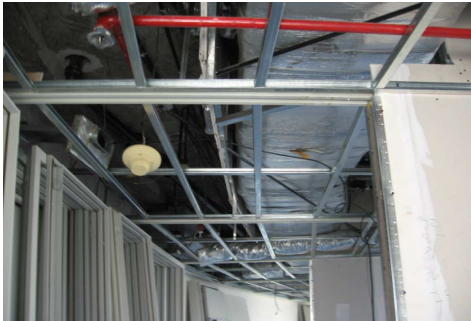
NUEVOS CIELORRASOS - ESTRUCTURA METALICA
