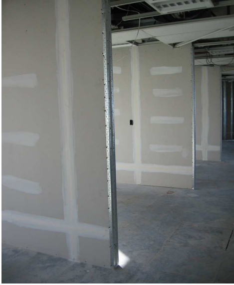
NUEVOS TABIQUES - EMPLACADO DE CARA DOS, ENCINTADO Y MASILLADO
