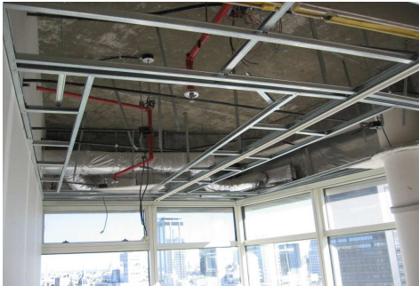
NUEVOS CIELORRASOS - ESTRUCTURA METALICA
