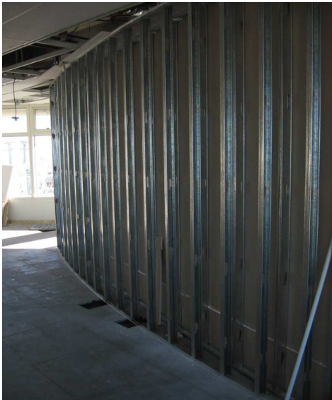
TABIQUES CURVOS EN COFFEES - ESTRUCTURA METALICA Y EMPLACADO DE CARA UNO
