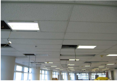
PUESTA A PUNTO Y REINSTALACION DE ARTEFACTOS EXISTENTES SEGUN NORMATIVAS VIGENTES - PRUEBA DE CIRCUITOS
