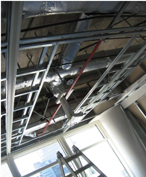
NUEVOS CIELORRASOS - ESTRUCTURA METALICA
