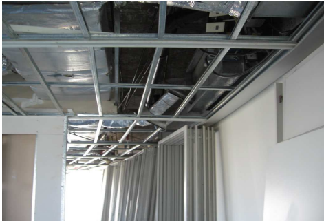
NUEVOS CIELORRASOS - ESTRUCTURA METALICA
