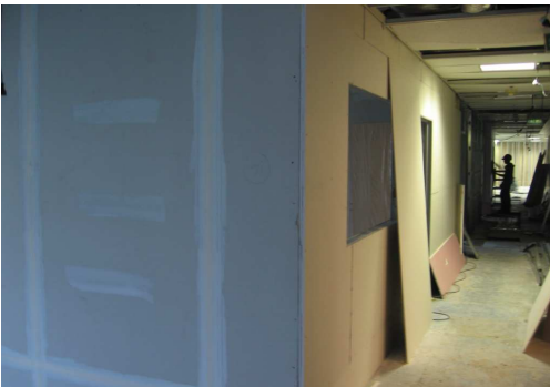
MASILLADO DE NUEVOS TABIQUES.
