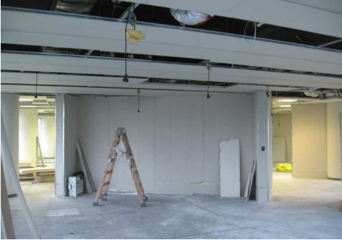
NUEVOS CIELORRASOS EN SECTORES COFFEE.
