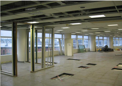
PRUEBA CIRCUITOS ILUMINACIÓN Y REARMADO CIELORRASOS DESMONTABLES.
