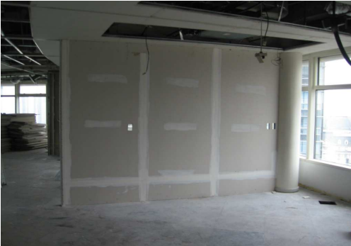
MASILLADO DE NUEVOS TABIQUES.
