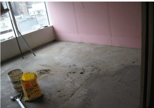
NUEVA CARPETA BAJO PISO TÉCNICO EN DATA CENTER.
