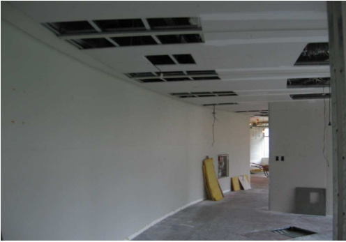
EMPLACADO DE NUEVOS CIELORRASOS CONTINUOS.
