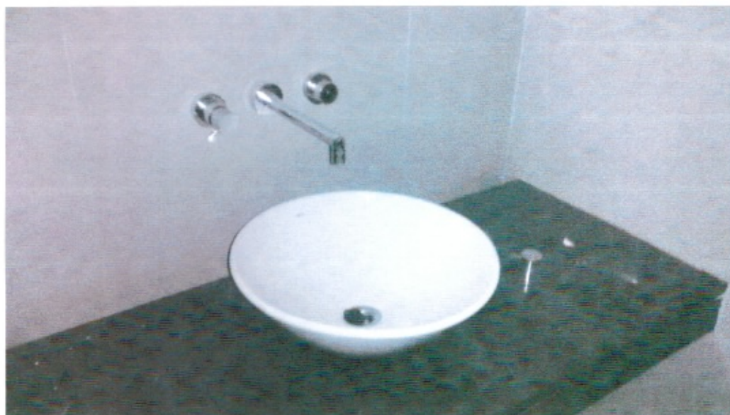
FOTO 17/18: Estado del baño privado de PB.
