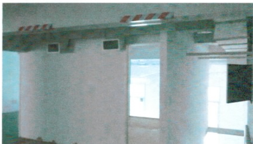
FOTO 1/2/3: Vista del Entrepiso
