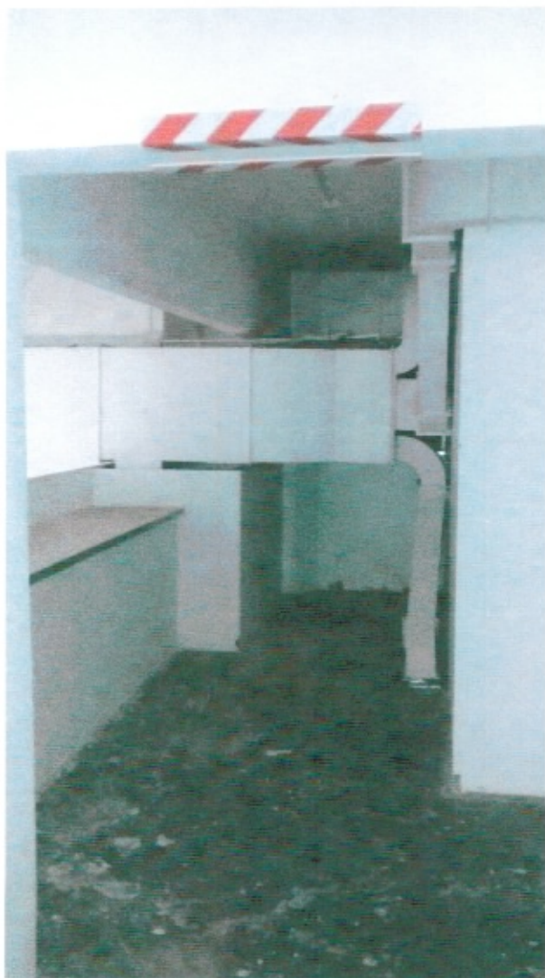
FOTO 6/7: Vista a los conductos existentes y unidad exterior central
