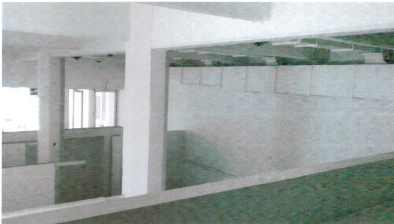
FOTO 4/5: Vista del entrepiso a la PB
