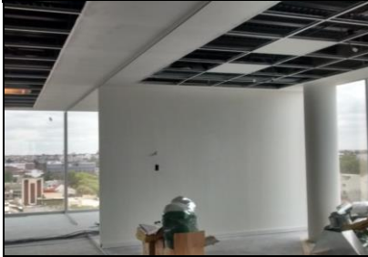
Tabiques durlorck pintura y preparación
