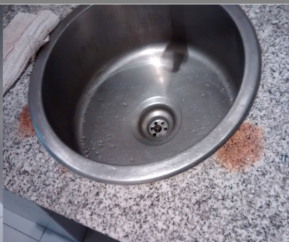
óxido en mesada de cuarto de limpieza.
