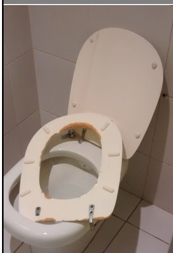
Se observa una tapa suelta de inodoro y la otra en mal estado.
