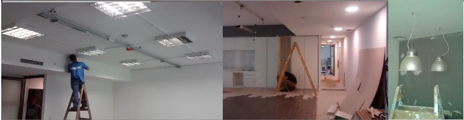
Colocación de luminarias
