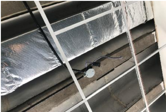
CABLEADO DE ILUMINACIÓN EN CIELORRASO
