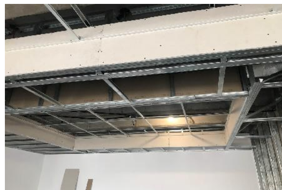
ARMADO DE CIELORRASO DESMONTABLE Y JUNTA TOMADA DURLOCK
