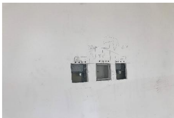
CAÑERÍA VACÍA PARA INSTALACIONES ELECTRICAS + CABLEADO DE ILUMINACION
