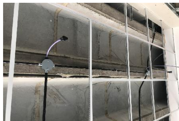
CAÑERÍA VACÍA PARA INSTALACIONES ELECTRICAS + CABLEADO DE ILUMINACION
