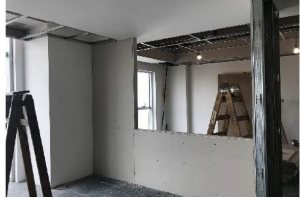
ARMADO DE TABIQUES + REFUERZOS DE MADERA EN CARPINTERÍAS
