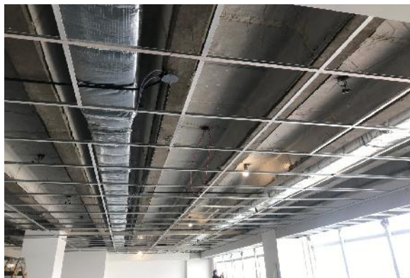
ARMADO DE CIELORRASO DESMONTABLE Y JUNTA TOMADA DURLOCK
