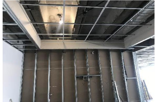
CAÑERÍAS VACÍAS EN TABIQUES DE DURLOCK + EMPLAQUE DE UNA CARA
