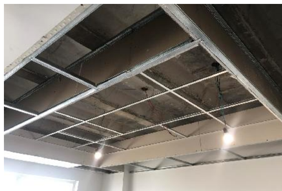
ARMADO DE CIELORRASO DESMONTABLE Y JUNTA TOMADA DURLOCK
