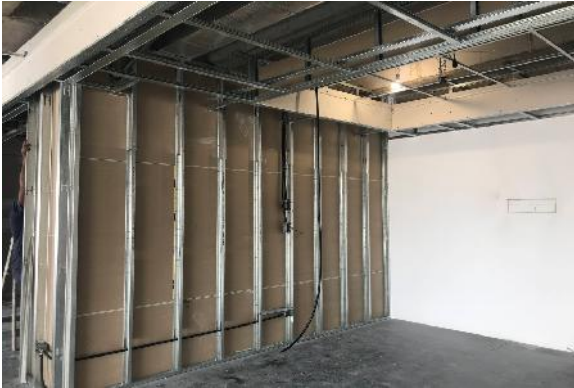
CAÑERÍAS VACÍAS EN TABIQUES DE DURLOCK + EMPLAQUE DE UNA CARA
