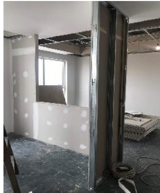
ARMADO DE TABIQUES + REFUERZOS DE MADERA EN CARPINTERÍAS
