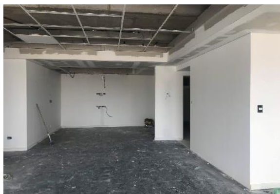
PREPARACION DE TABIQUES Y CIELORRASOS
