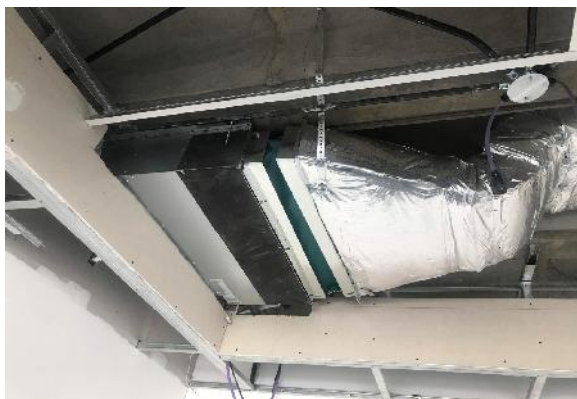
COLOCACION DE EQUIPOS Y CONDUCTOS DE AA
