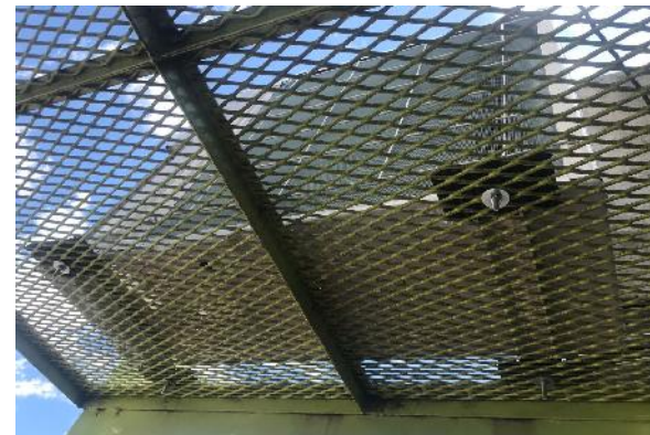
COLOCACION DE CONDENSADORA EN TERRAZA
