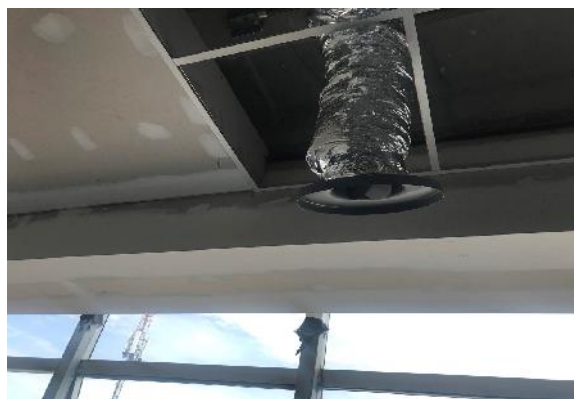
COLOCACION DE EQUIPOS Y CONDUCTOS DE AA
