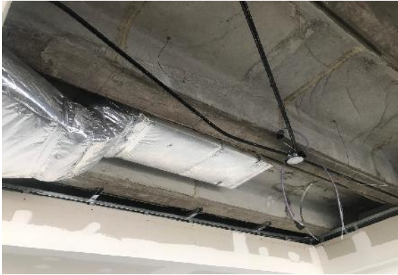
COLOCACION DE EQUIPOS Y CONDUCTOS DE AA
