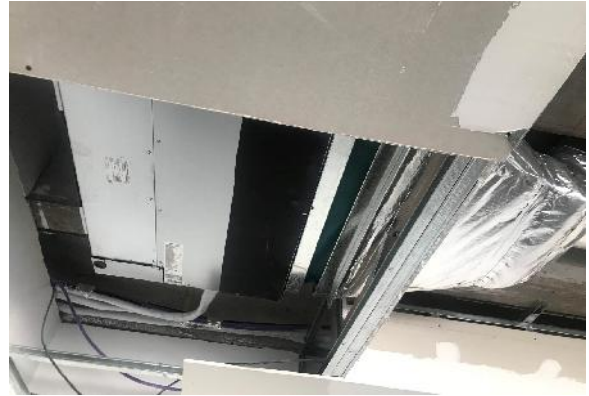
COLOCACION DE EQUIPOS Y CONDUCTOS DE AA
