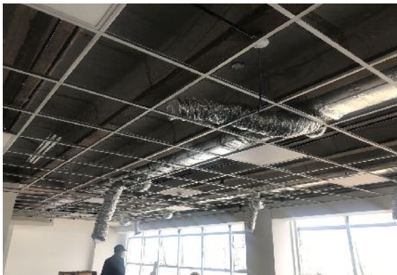
COLOCACION DE EQUIPOS Y CONDUCTOS DE AA
