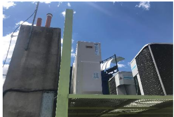
COLOCACION DE CONDENSADORA EN TERRAZA
