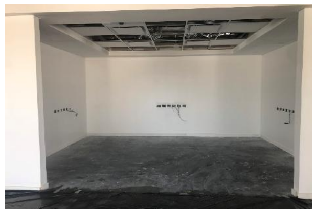
PREPARACION DE TABIQUES Y CIELORRASOS
