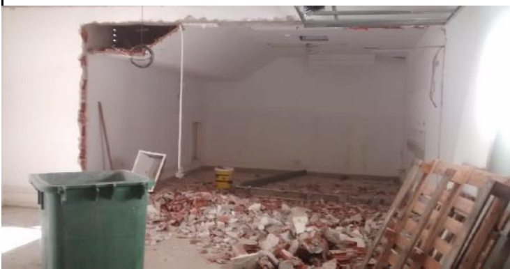
Se demolió tabique del piso 3 y se realizaron las canalizaciones. Piso 5 comenzaron a levantar la estructura de tabiques.
