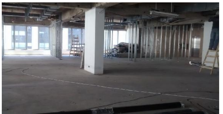
Se demolió tabique del piso 3 y se realizaron las canalizaciones. Piso 5 comenzaron a levantar la estructura de tabiques.
