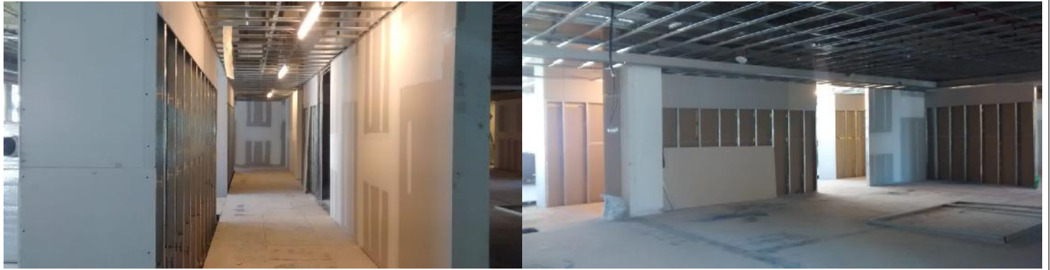
Piso 8 se armó la estructura de cielorrasos y ajuste
