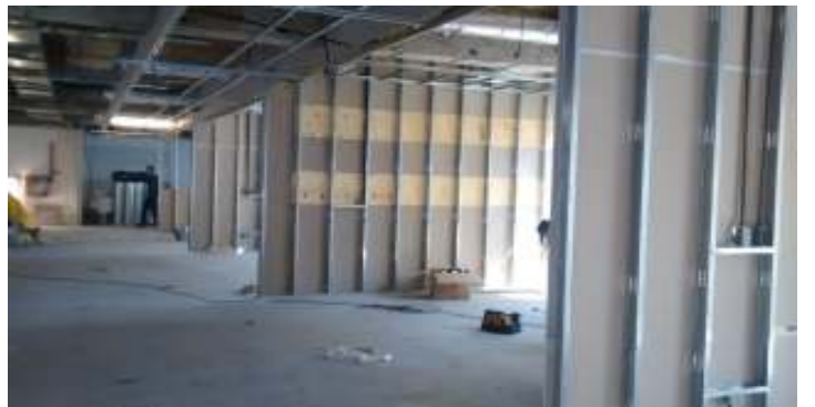
Piso 4. Se terminó la demolición, se avanza con refuerzos de madera en tabiques, estructura de cielorrasos y AA.
