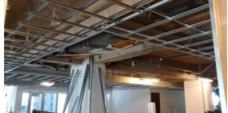
Piso 3. Se armó la estructura de los cielorrasos ajustes. Se está emplacando las segundas caras.
