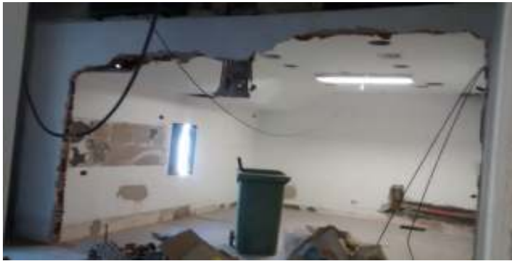
Piso 4. Se terminó la demolición, se avanza con refuerzos de madera en tabiques, estructura de cielorrasos y AA.
