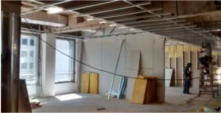
Piso 5. Se avanza con estructura de cielorrasos y ajustes. También se avanza con AA, montaje de tachos y cañerías.
