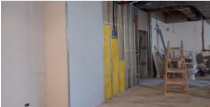
Piso 3. Se armó la estructura de los cielorrasos ajustes. Se está emplacando las segundas caras.
