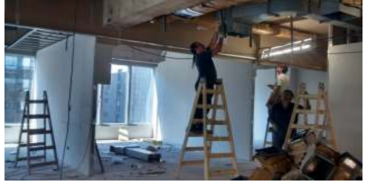
Piso 5. Se avanza con estructura de cielorrasos y ajustes. También se avanza con AA, montaje de tachos y cañerías.
